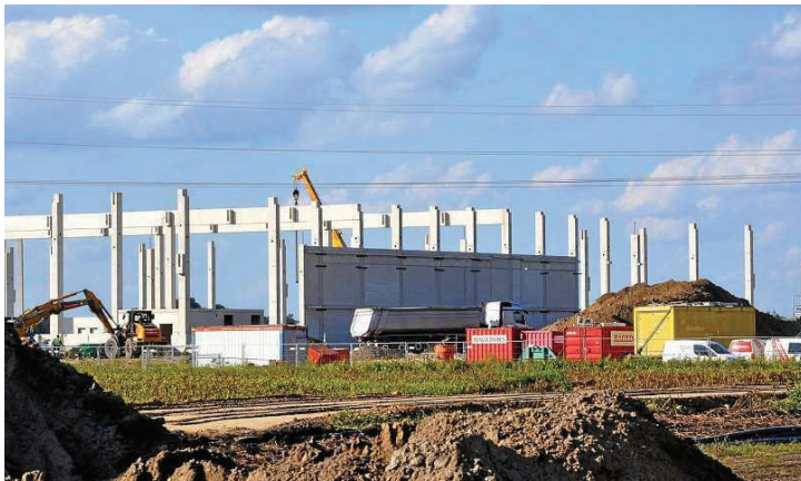
Jüngstes Großprojekt im Landkreis Gifhorn: Im Triangelger Gewerbegebiet Rohrwiesen baut das Wolfsburger Unternehmen Schnellecke Real Estate (SRE) eine rund 18.000 Quadratmeter große Produktionshalle, in der ab April 2024 mit der Montage von Achsen für das VW-Elektromodell ID.3 begonnen werden soll.
