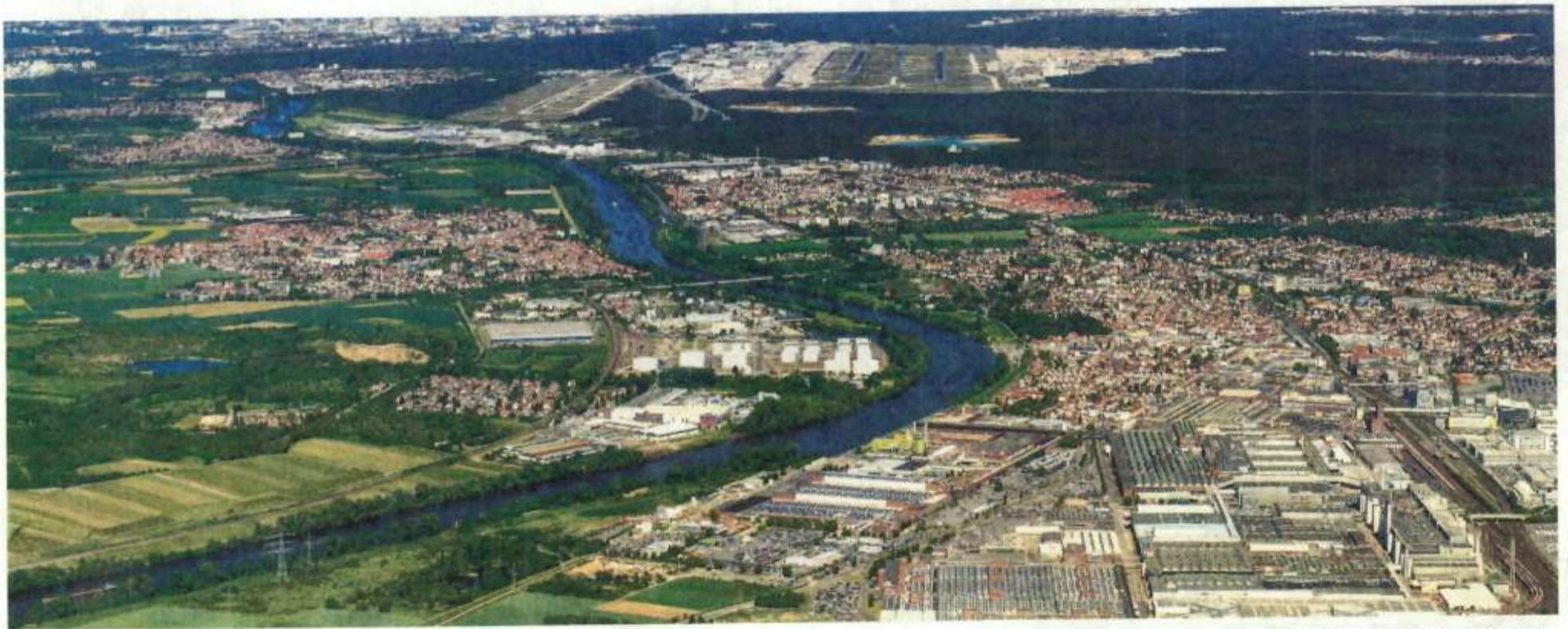
Die Nähe zum Frankfurter Flughafen (hinten, Mitte) soll einer der belebenden Faktoren für die Flächen werden, die das Opelwerk (vorne, rechts) nicht mehr benötigt. Quelle: image, Urheber: JOKER
